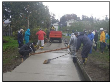
【農道舗装の様子】
