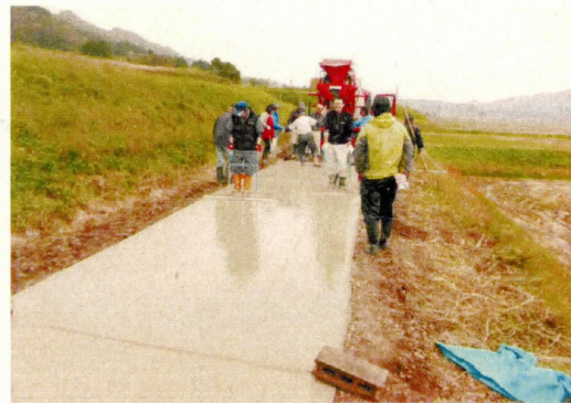
【農道の舗装作業】
