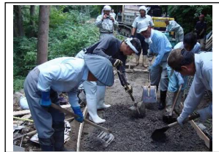
【住民による舗装作業の状況】
