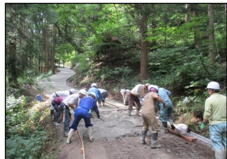
【農道舗装の様子】
