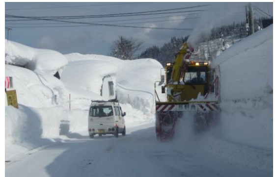
国道 117 号の除雪作業
