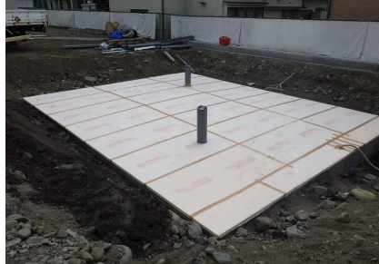
写真-4 地中熱交換槽天端断熱材敷設状況
