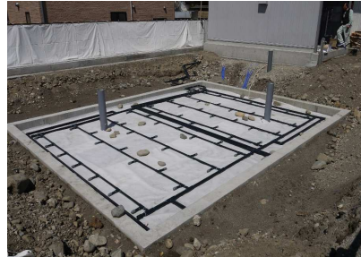
写真-2 地中熱交換槽散水パイプ敷設状況
