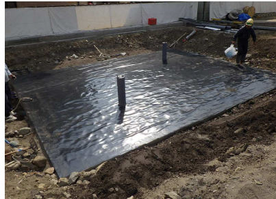
写真-3 断熱材上面遮水シート敷設
