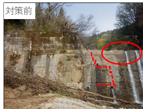
そのほらがわ そのほら (砂) 園原川 阿智村園原 砂防堰堤の改築により、施設の機能及び性能を適切に維持・確保
