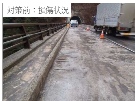
つがぞくらばし (国) 158号 松本市柵桜橋 損傷した床板を補修し、機能を適切に維持
