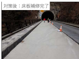
つがぞくらばし (国) 158号 松本市柵桜橋 損傷した床板を補修し、機能を適切に維持
