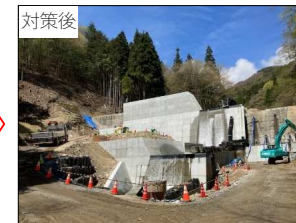
そのほらがわ そのほら (砂) 園原川 阿智村園原 砂防堰堤の改築により、施設の機能及び性能を適切に維持・確保
