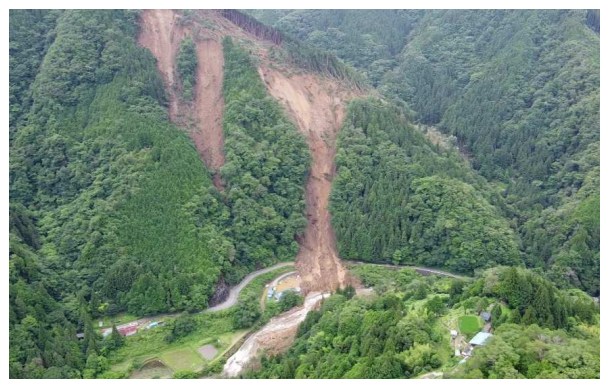
令和 2 年 7 月豪雨により大規模な山腹崩壊が発生 あしげ (国) 418号 天龍村 足瀬
