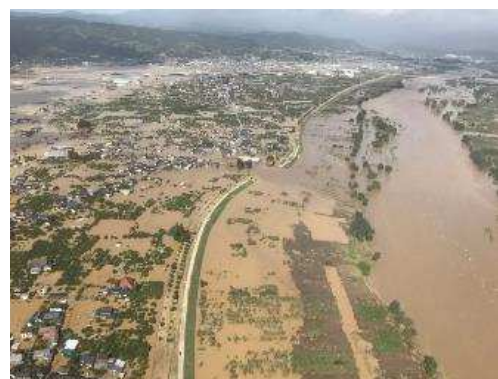
令和元年10月 東日本台風により千曲川堤防が決壊 ほやす (一) 千曲川 長野市 穂保
