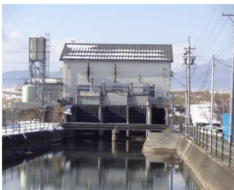
福島北排水機場
