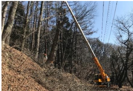
ライフライン沿いの危険木伐採
