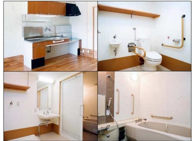
身体障がい者向け住宅リフォーム（公営住宅の施工例）
