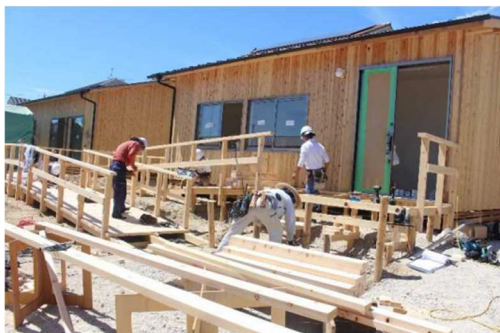
応急仮設住宅の建設 (出典：国土交通省)
