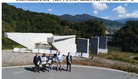
[橋梁施工状況 (公共事業評価委員会の現地調査)]
