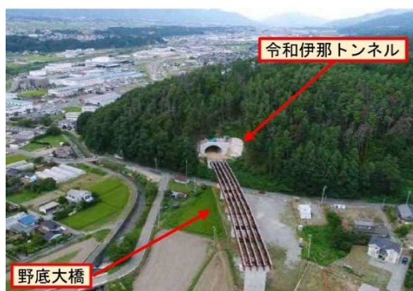
工事が進むトンネルと橋梁
