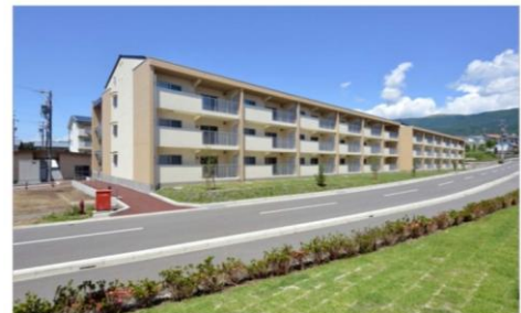
公営住宅の協働建替え (君石団地：塩尻市)
