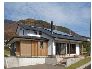
県産木材を利用した木造住宅
