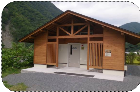
○大鹿村 [ビガーランド公衆トイレ]
