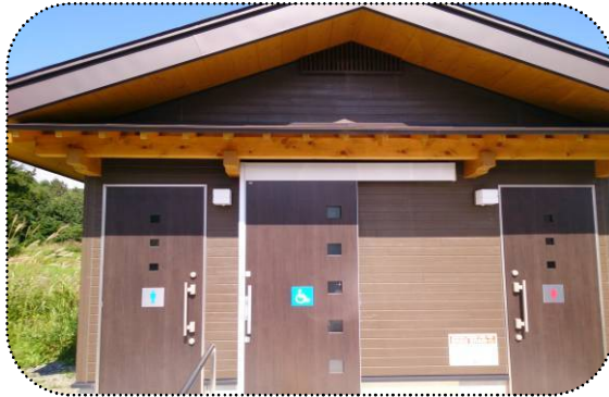
○木曾町 [開田高原 管沢公衆トイレ]
