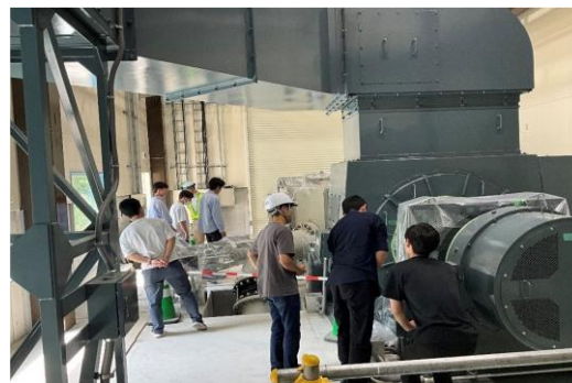
信州大学工学部による発電所見学
