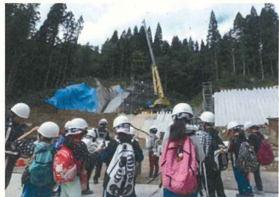
砂防工事の説明状況（小谷小）
