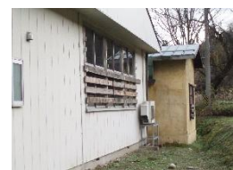
事務所も冬支度(窓に雪囲い)
