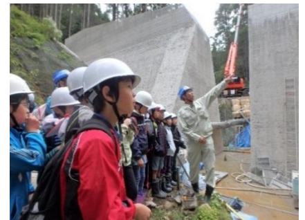
建設中の砂防ダムを見学
