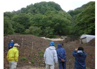
現地調査の状況【小谷村(砂)滝の沢】
