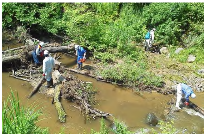
白馬村峰方沢での流木処理
