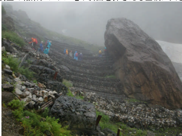
「赤岩」周辺に設置したフトン籠工と現地調査の状況
