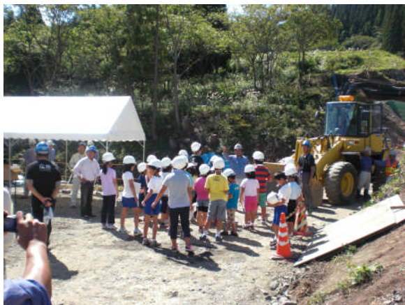
ジヨバラーに乗ってみよう（虫尾砂防工事）
