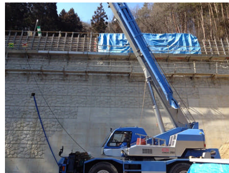
砂防堰堤前面の様子
