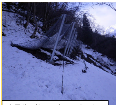
大雪前に施工は完了しました
