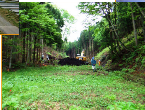
西東原沢砂防堰堤 着工前状況
