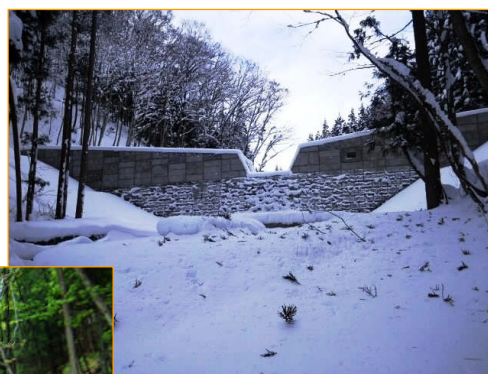
西東原沢砂防堰堤 竣工状況
