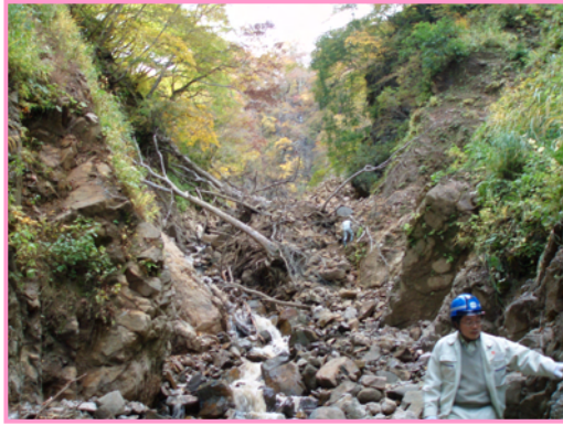
<濁沢上流の土砂崩落状況>
