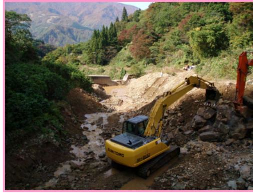
<11号堰堤の土砂除去状況>
