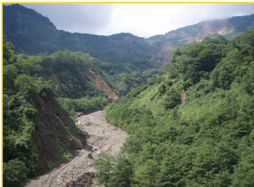
金谷橋から見た浦川と稗田山崩れ(写真上部)
