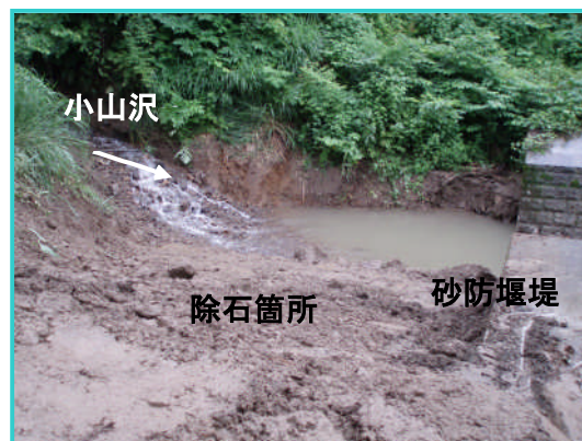
除石した小山沢上流の砂防堰堤
