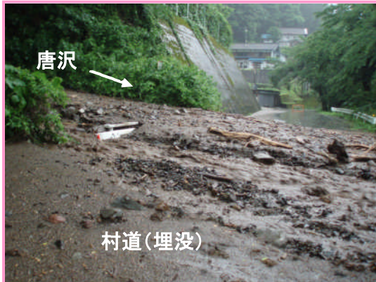
土石流で埋没した村道橋(左にガードレールがわずかに見える)
