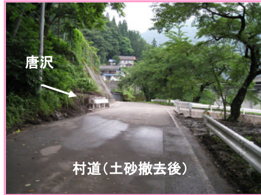
土砂撤去後の状況
