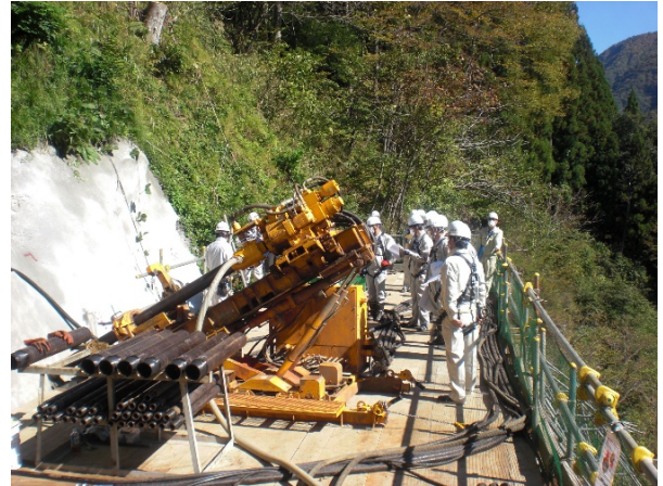
足場上での研修
