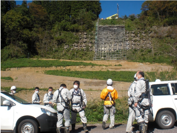
(緊) 神久工区全景
