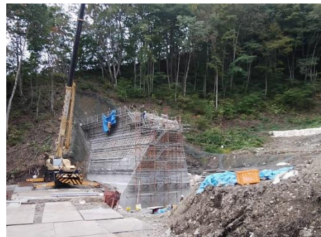
堰堤右岸袖部
