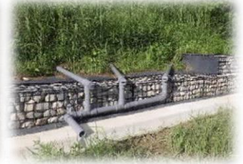
横ボーリング工
