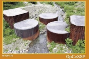
土谷川奉納鋼製セル埋堤
