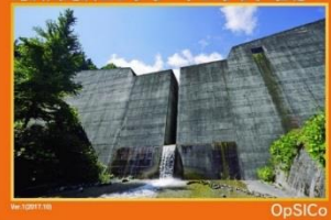
滝沢川滝沢コンクリートスリット埋堤
