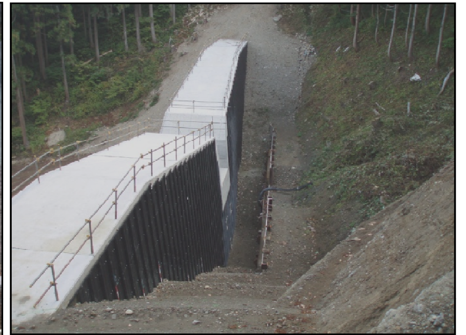
完成した砂防堰堤
