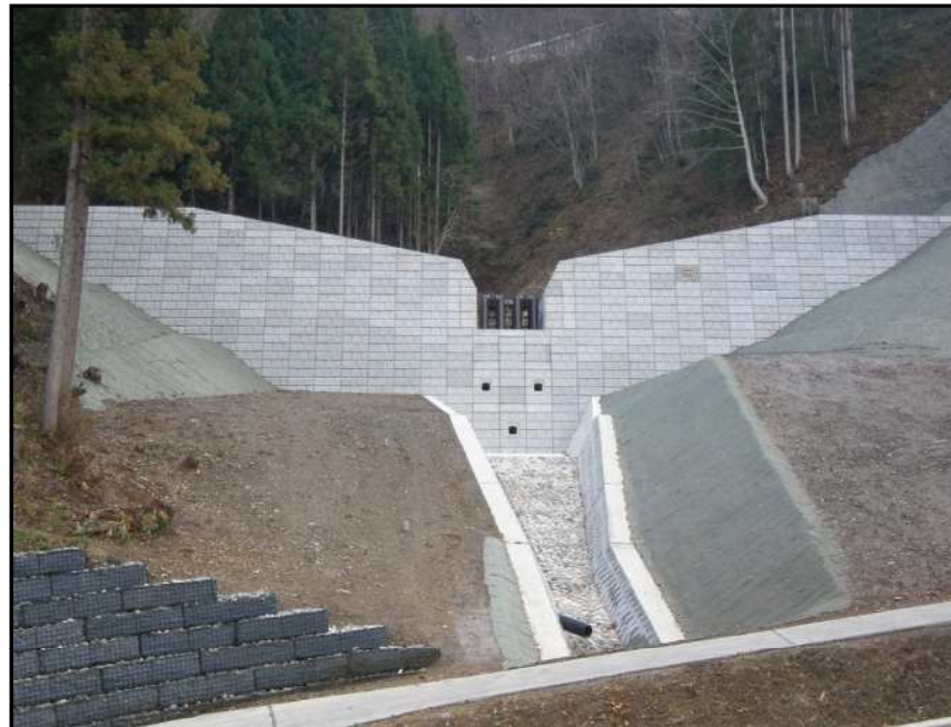
完成した砂防堰堤
