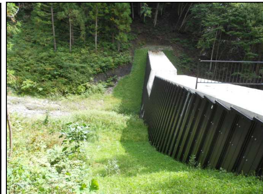
完成した砂防堰堤
