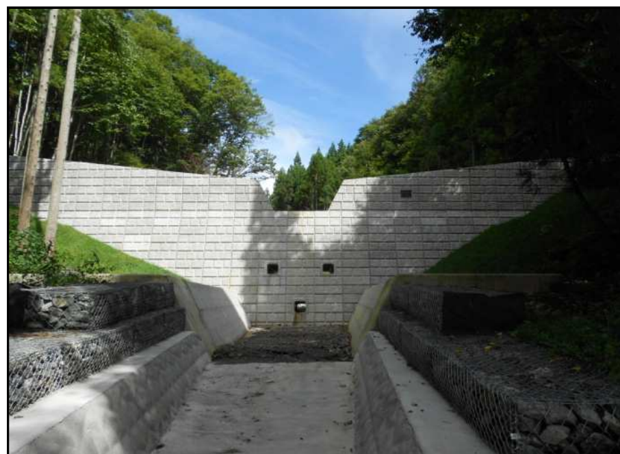
完成した砂防堰堤
