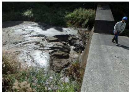
H29豪雨で土砂捕捉(砂)くるみ沢
