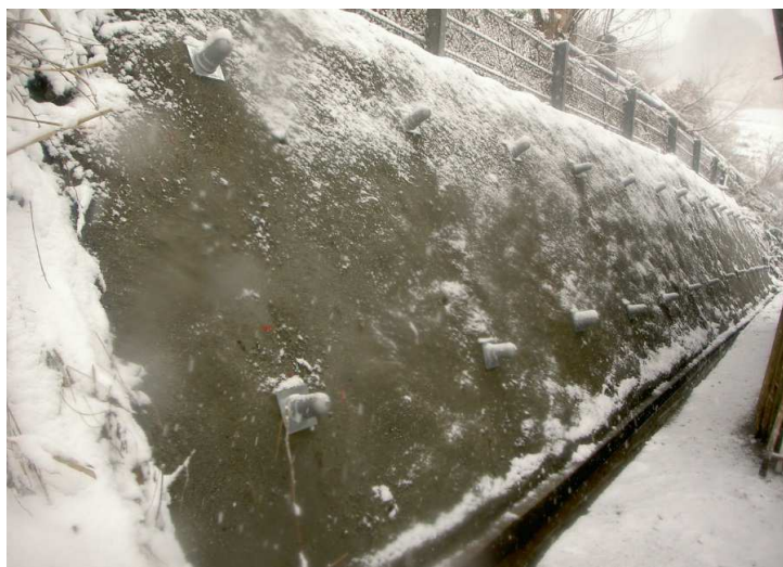
擁壁補修工完成状況
