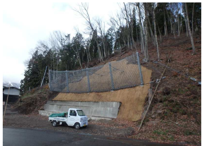
2工区 アンカー式防護柵設置状況
