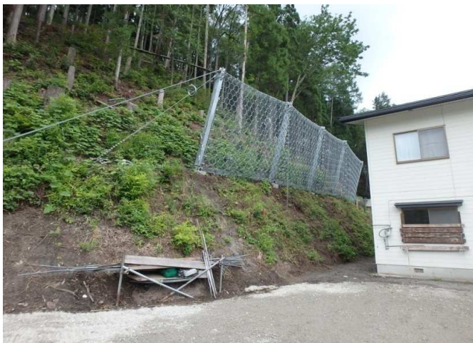
1工区 アンカー式防護柵設置状況
