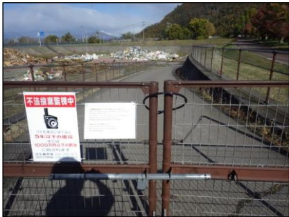
仮置場入口の施錠（須坂市）
