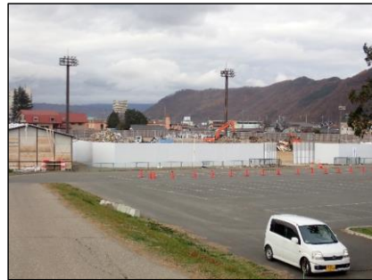
飛散防止の仮囲い（千曲市）
