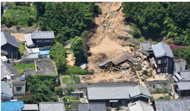
上怒和地区（怒和島） 被災状況
