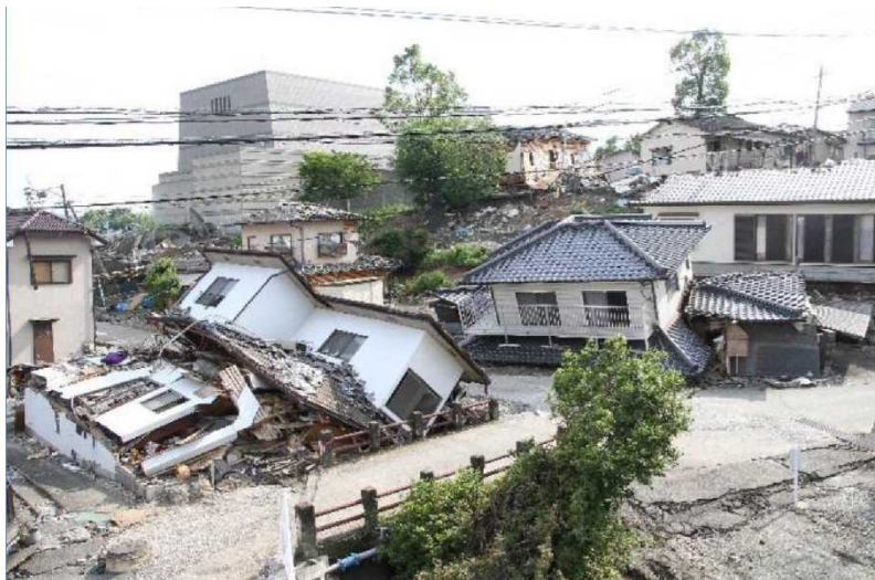
公費解体が必要な家屋
