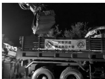
自衛隊による搬出作業
