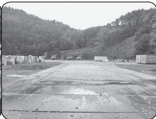
仮置場の敷き鉄板
