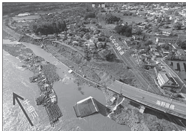
橋梁損壊（東御市）
