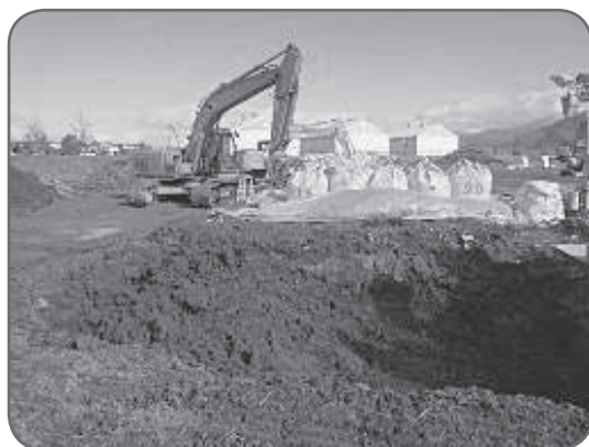
土砂混じりがれきの凝固作業
