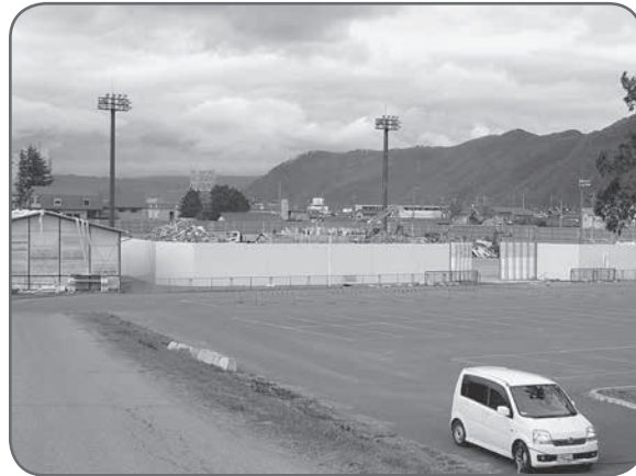
仮置場の仮囲い
