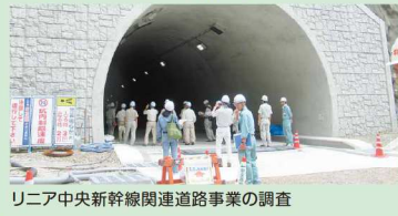
リニア中央新幹線関連道路事業の調査
