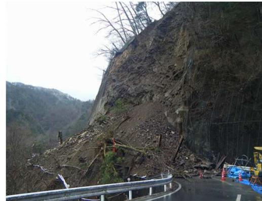
天龍村の生命線が法面の劣化により崩落
