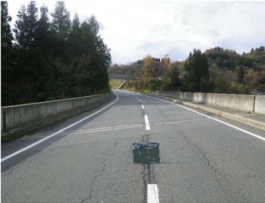
経年劣化や大型車両の交通による橋面舗装・伸縮装置の破損
