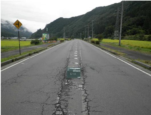
経年劣化や大型車両の交通による路面破損走行の安全性や快適性を阻害
