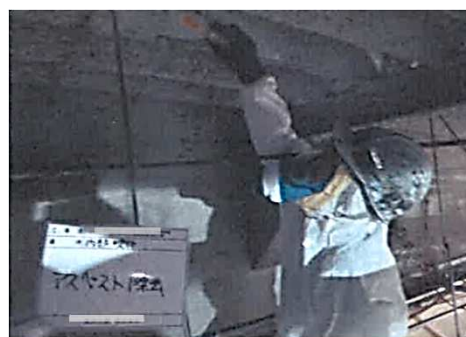
除去作業状況
