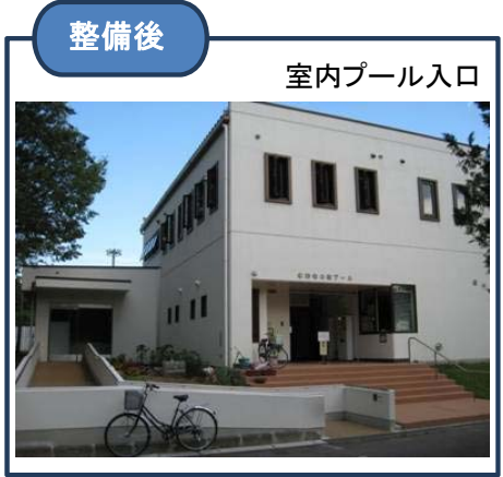
スロープを新設することで 誰もが使いやすく改善
