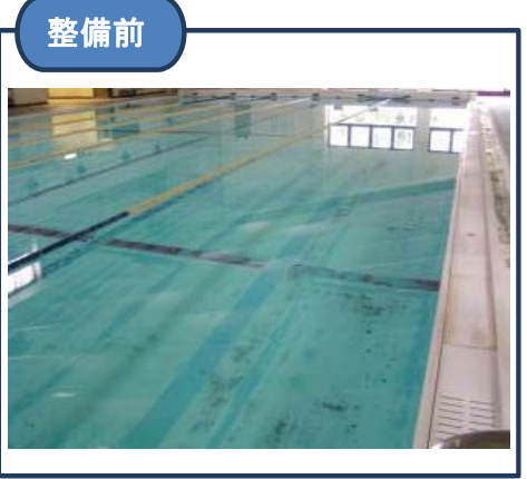
プールの水槽の塗装が劣化
