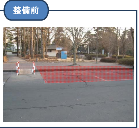
障がい者用駐車スペースは あるが、移動がしにくい
