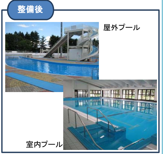
水槽の塗装を改修 階段を新たに設置(室内)
