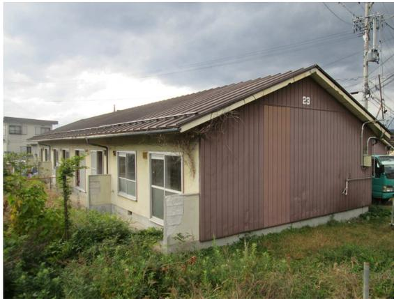
○老朽化した公営住宅を良質なストックへ再生するため、外壁・床・天井・サッシの断熱性向上や段差解消・手すりの設置などバリアフリー化を行い、居住性を向上させた。
