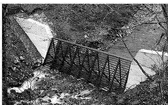
写真 9-4-8 バットレス型スクリーン式砂防堰堤
