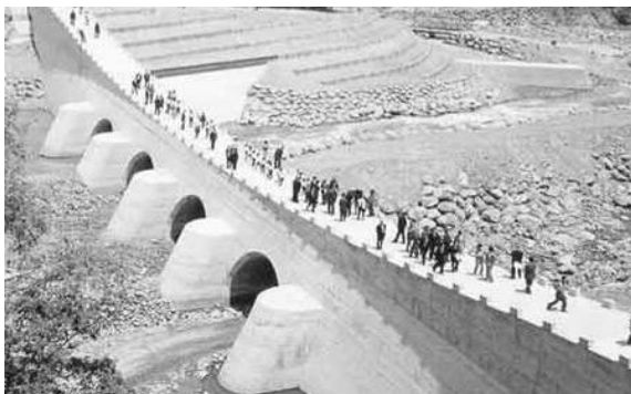
写真 9-4-3 大暗渠式（スーパー暗渠式）砂防堰堤
