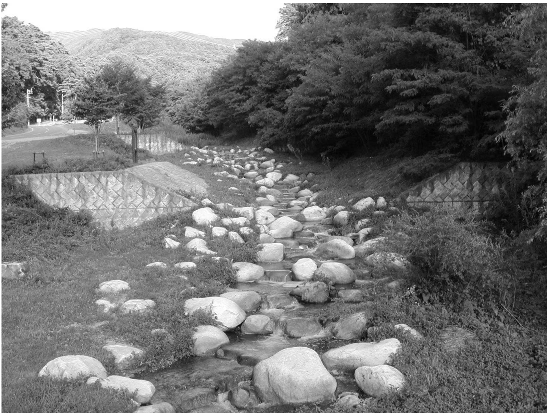
写真 5.6 分散型床固工の事例
