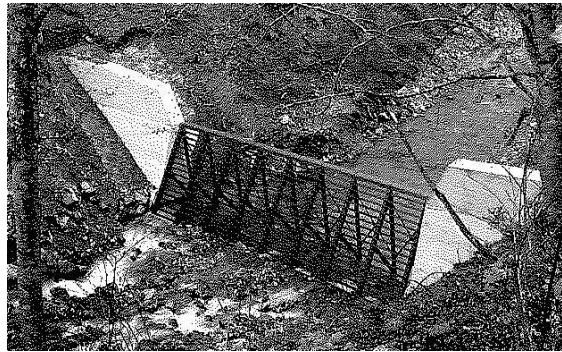
写真 1.3.3(i) バットレス型スクリーン砂防えん堤
