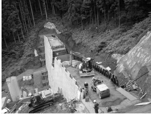
写真 1.3.4(e) ソイルセメント砂防えん堤
