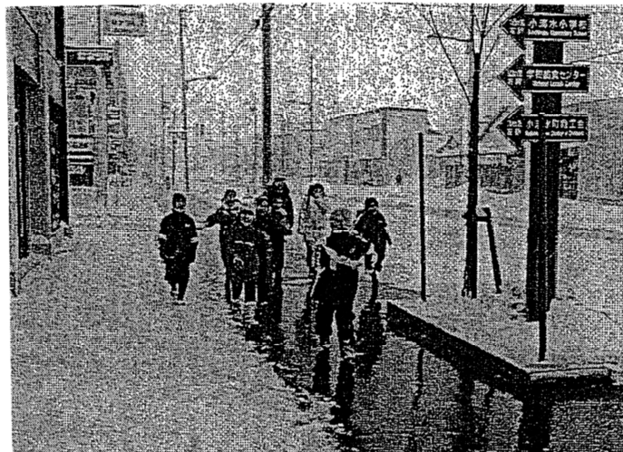
写真8-5-1 無散水消雪状況
