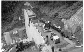
写真 9-4-12 砂防ソイルセメント砂防堰堤
