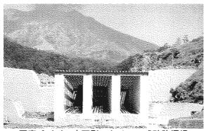
写真 9-4-4 底面型スクリーン式砂防堰堤
