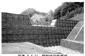
写真 9-4-11 鋼製枠砂防堰堤
