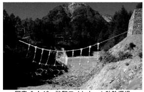
写真 9-4-10 強靭ワイヤネット砂防堰堤
