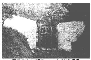
写真 9-4-6 鋼管フレーム式砂防堰堤
