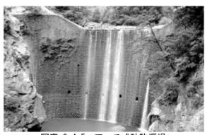
写真 9-4-5 アーチ式砂防堰堤
