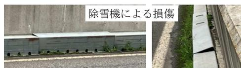
近隣の橋梁調査で除雪機による損傷が確認されたことから、除雪作業に配慮した耐久性に優れた排水装置を選択することで、当該地に最適な排水装置を提案することができた。
