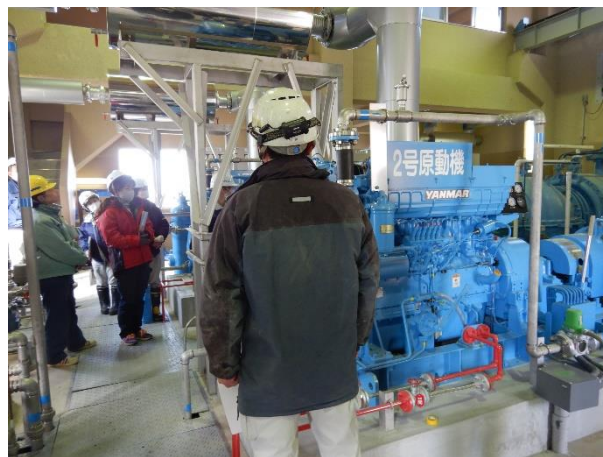
排水機場の施設内部を見学
