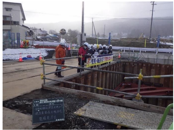
仮設土留・床掘の様子を確認
