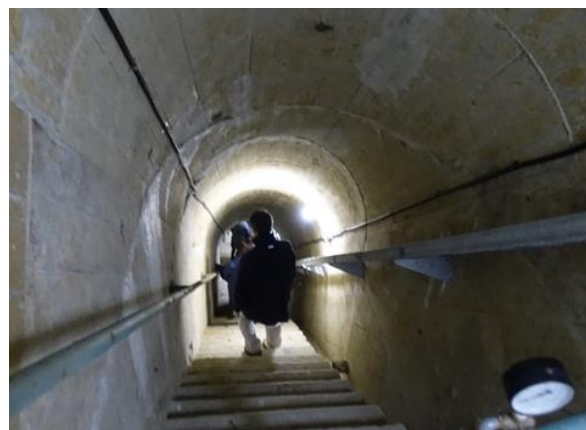
監査廊の見学
