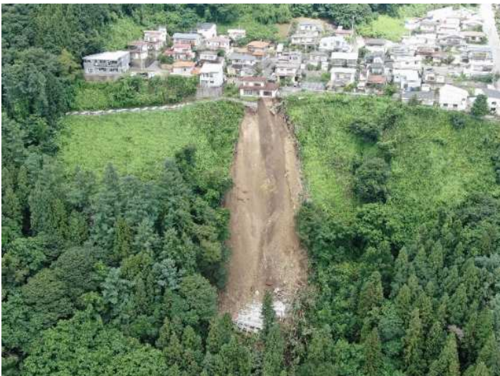
急傾斜地の崩壊 (長野市)
