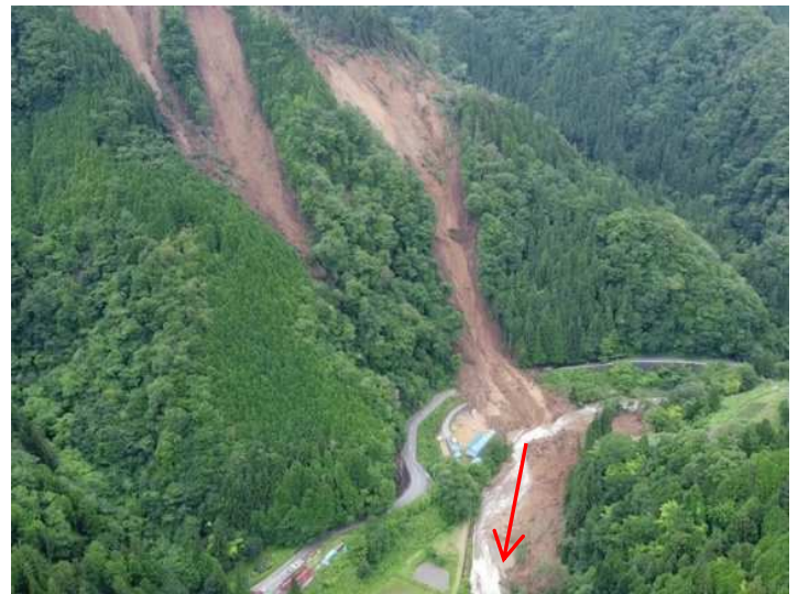
(国) 418号への大規模な土砂崩落 (天龍村)
